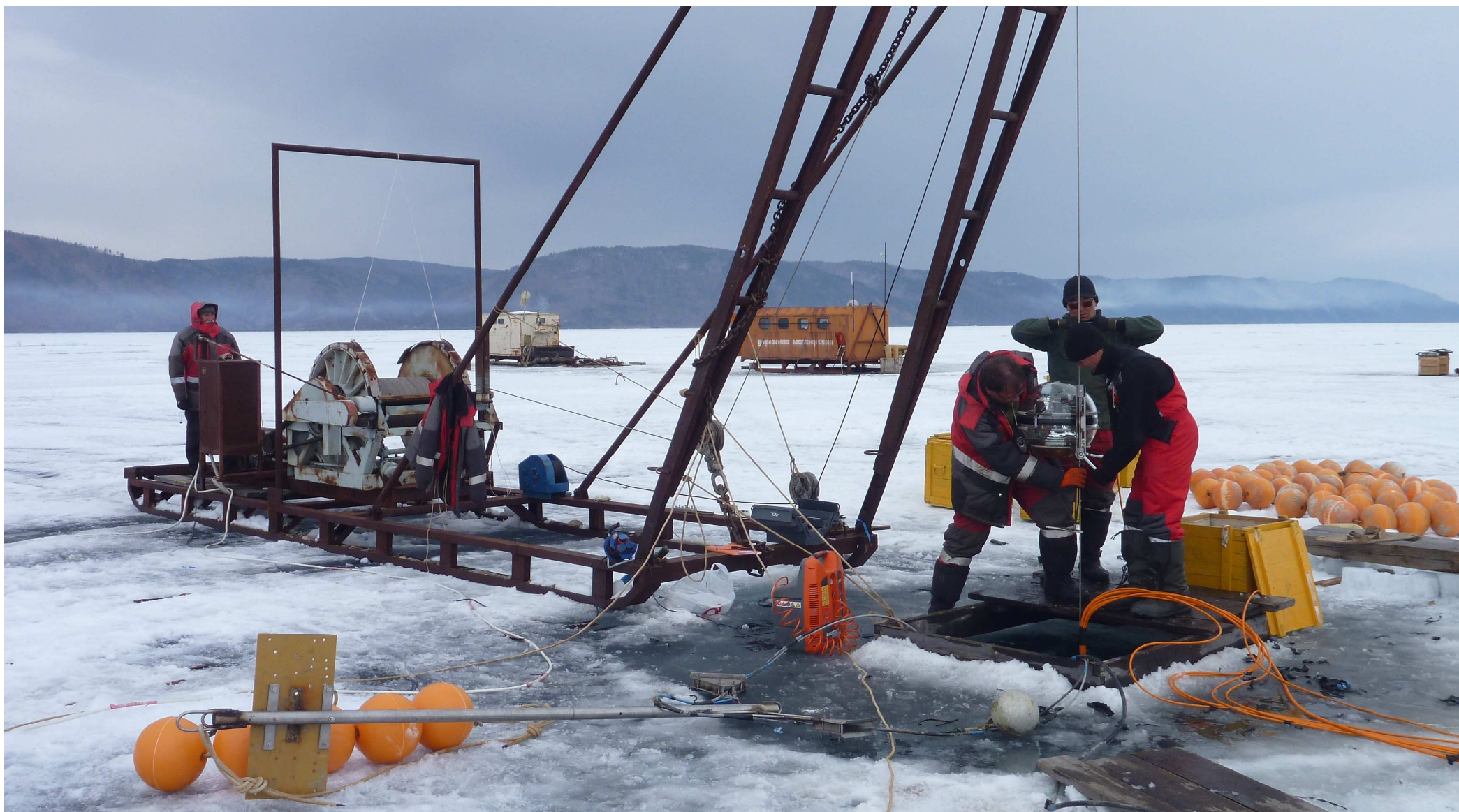
04. Монтаж гирлянды оптических модулей. Команда из 4 человек устанавливает гирлянду в рабочий режим, включая тестирование, за 4-6 рабочих дней.
