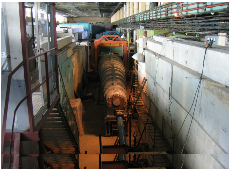
Общий вид установки ОКА
