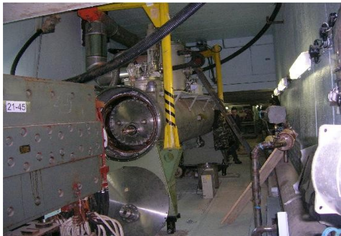
RF1 дефлектор в канале
