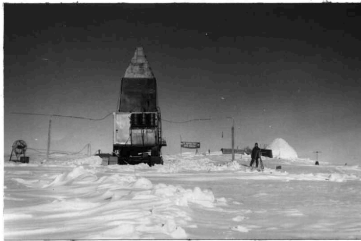
Рис. 1 Работы на нейтринном полигоне станции "Восток". На переднем плане передвижная буровая установка. На заднем - балок (над снегом видна только крыша). Купол рядом - иглу, используемая как наружный склад.
